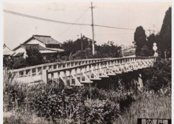
写真① 古い屋戸橋
