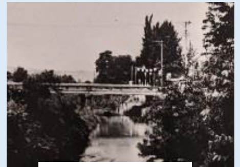
写真① 古い天神橋
